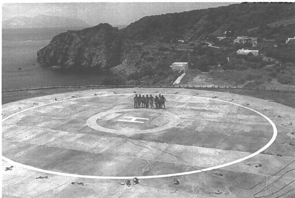
*Fig. 9 – Esempio di elisuperficie realizzata con lastre di calcestruzzo non armato presso le Isole Eolie*
