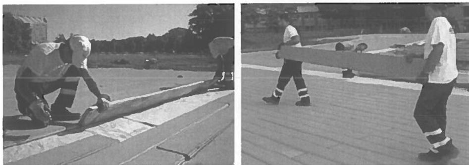
*Fig. 7 – Fasi di montaggio sovrastruttura in alluminio*
