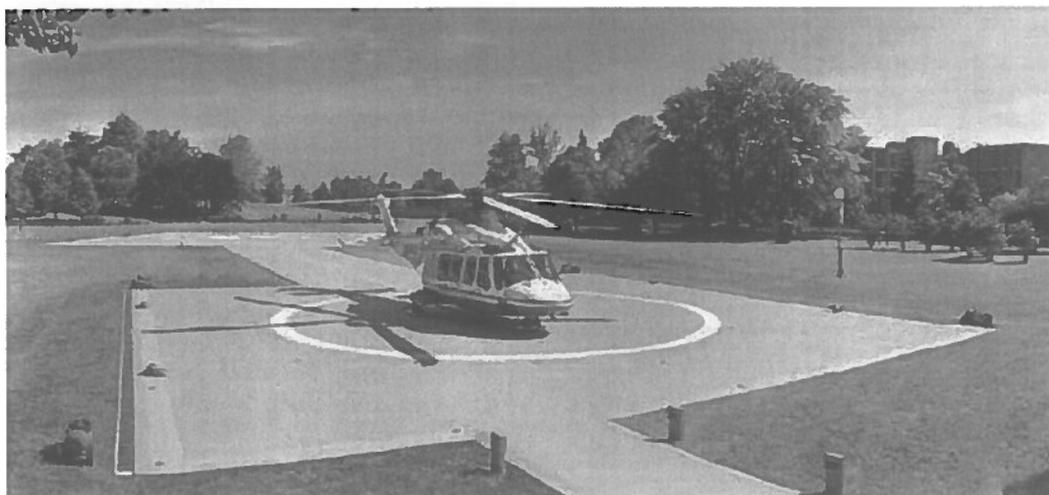
Fig. 6 – Esempio di elisuperficie realizzata con profili in lega di alluminio
