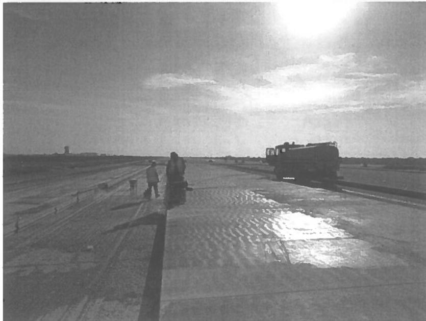
*Fig. 10 – Realizzazione sovrastruttura in calcestruzzo non armato: fasi di getto, rifinitura superficiale e taglio dei giunti*
